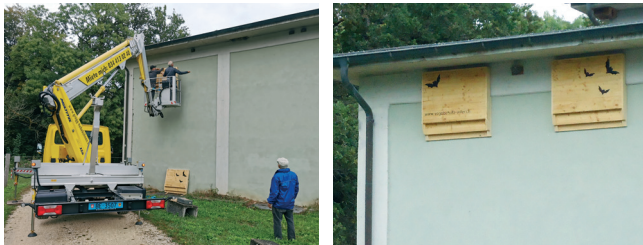
Montage von Fledermauskästen am Kraftwerk Moosbrunnen 1. Man rechnet mit dem Bezug im Sommer 2024
